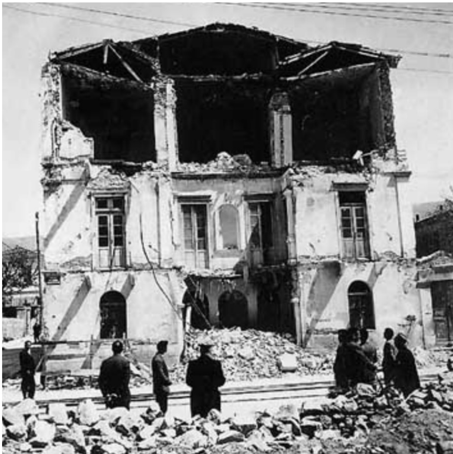
Βόλος 1955: κτίριο κατεστραμμένο από τον σεισμό
