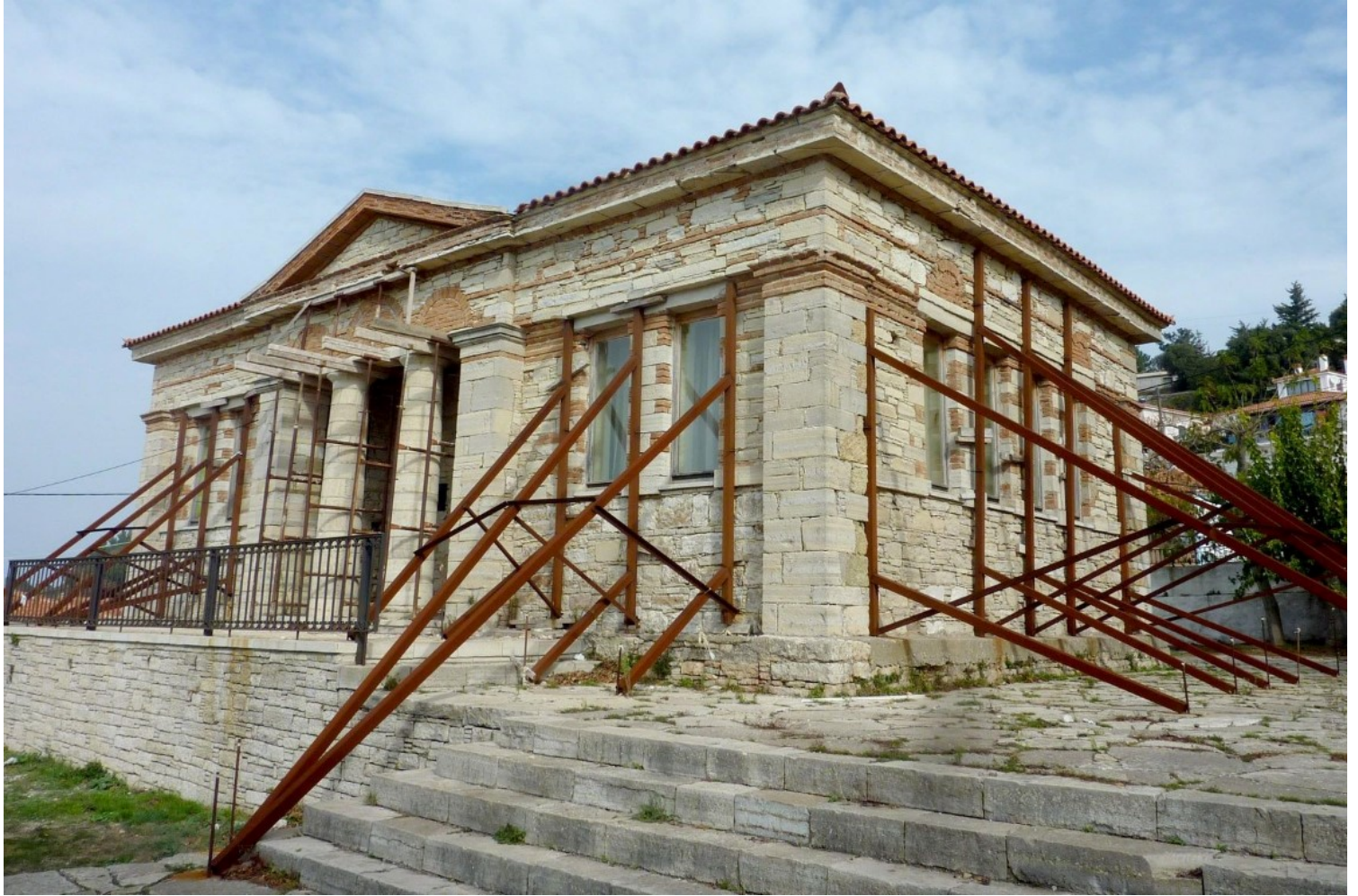
Δημοτικό σχολείο στον Πλάτανο Σάμου
