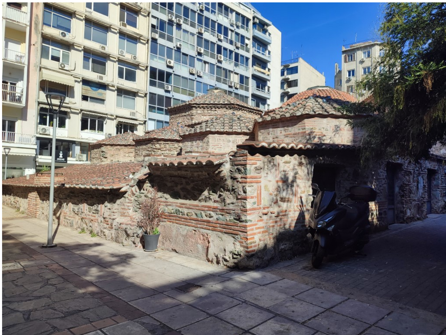
Εικ16: Κτίριο γραφείων (δεκ.1970) σε γειτνίαση με το Γιαχουντί Χαράμ στα Λουλουδάδικα (πηγή: προσωπικό αρχείο)
