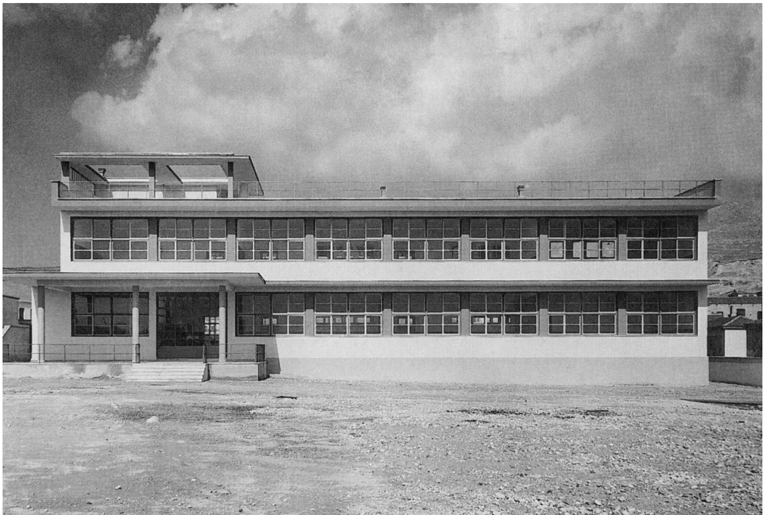
Δημοτικό Σχολείο Ταμπουρίων Πειραιώς (1932-1935) | Πηγή εικόνας: archetype.gr
