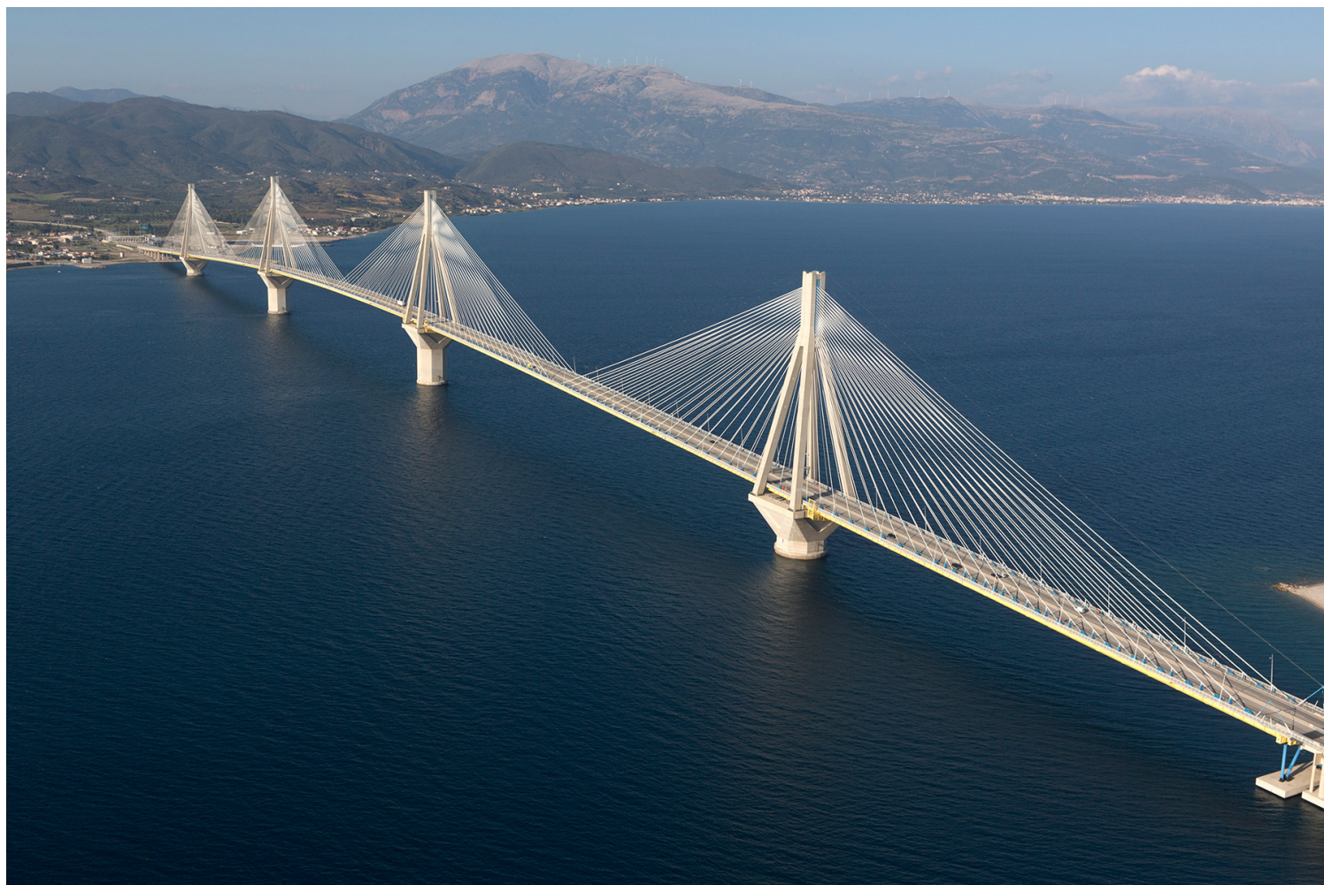
Γέφυρα Ρίου-Αντιρρίου | Πηγή εικόνας: titan.gr
