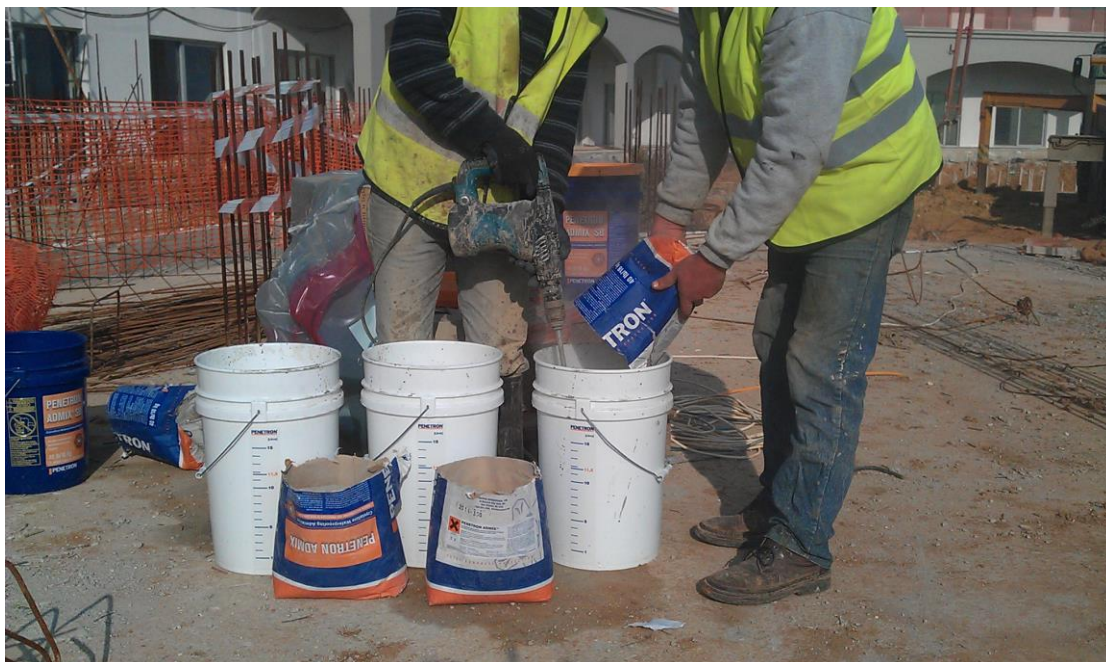
«Ανάμιξη του PENETRON ADMIX® με νερό στα ειδικά δοχεία ανάμιξης, πριν την προσθήκη στη “βαρέλα”»
