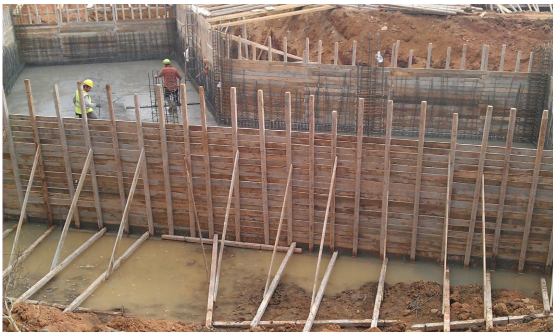
«Κατασκευή βιολογικού καθαρισμού μέσα σε νερο»
