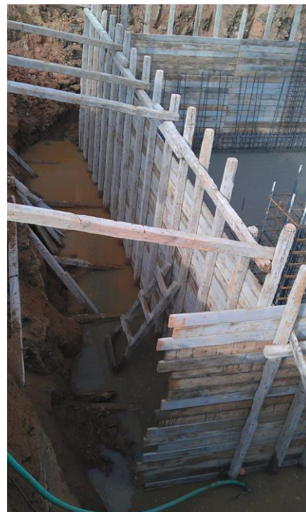
«Άποψη του έργου, κατά την αρχική φάση προετοιμασίας σκυροδέτησης του βιολογικού καθαρισμού»
