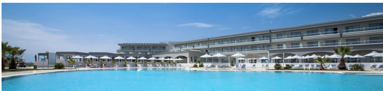
«Εγκαταστάσεις του πολυτελούς ξενοδοχειακού συγκροτήματος Blue Lagoon Princess *****»
