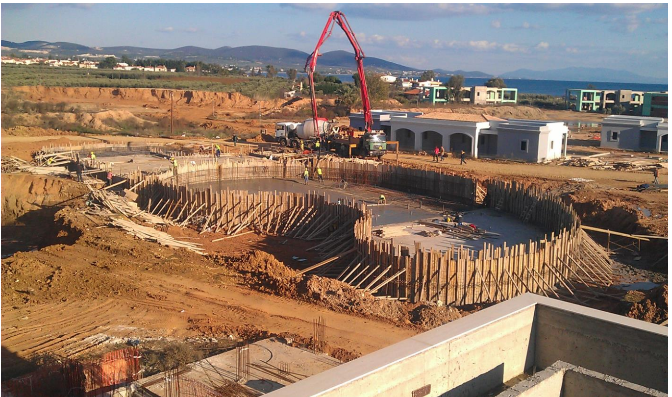
«Άποψη του έργου, κατά την αρχική φάση προετοιμασίας σκυροδέτησης της κεντρικής πισίνας»
