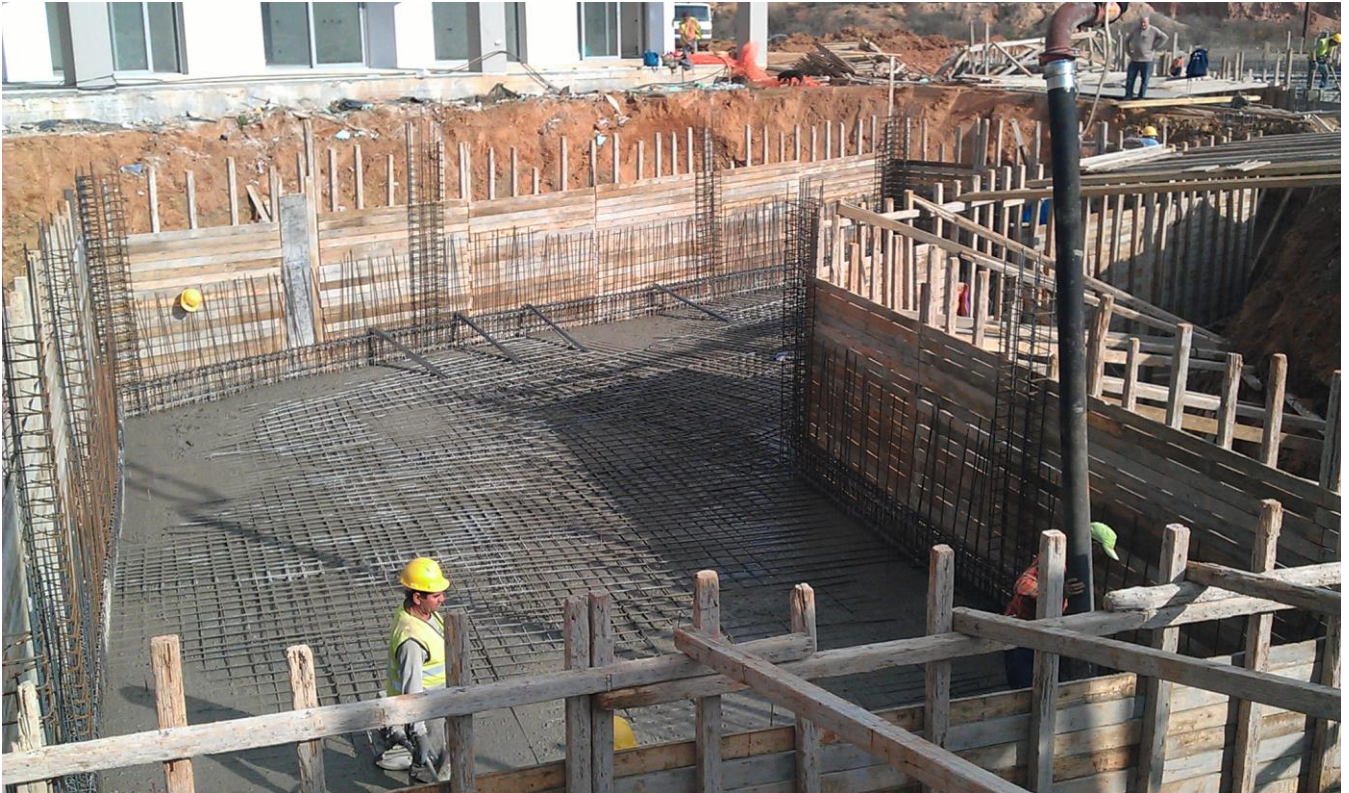
«Άποψη του έργου, κατά την αρχική φάση προετοιμασίας σκυροδέτησης του βιολογικού καθαρισμού»
